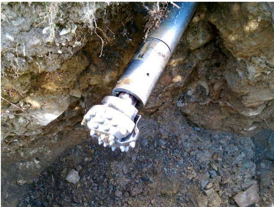
Bild 1: TERRA-ROCK 65 bohrt durch Mischboden
