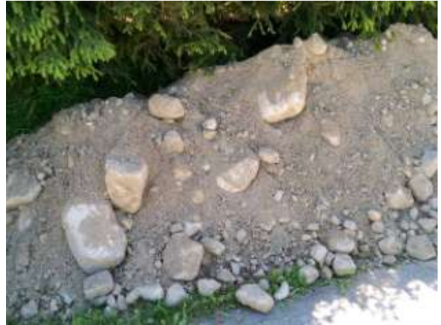
Bild 3: Mischböden sind oft eine grosse Herausforderung für Mensch und Maschine. Bei diesen 300 Querungen in Raufoss änderte sich der Boden von Kies über Grobkies bis hin zu blankem Fels - genau der richtige Einsatz für den TERRA-ROCK 65 mit dem TERRA Rock-Add 1304 für Flüssigkeitsbetriebene Felsbohrungen. Hier zeigen sich die Systemvorteile von Ihrer besten Seite!
