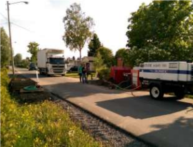
Bild 2: 300 Strassen wie diese müssen grabenlos für die Verlegung von Glasfaserkabeln passiert werden. Die Längen variieren von 7 - 18 m.
