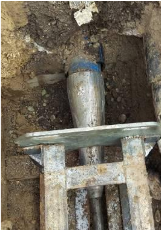
Bild 6: Aufweitkonus und Neurohr in der Zuggrube.
