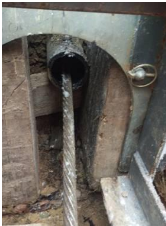
Bild 1: Das Zugseil ist in das Altrrohr eingezogen.
