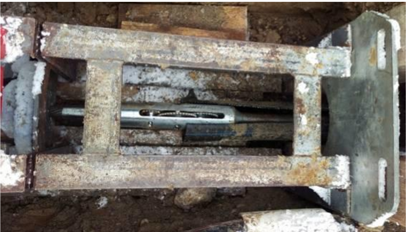
Bild 5: Das doppelte Zahnscheibenmesser erreicht die Zuggrube. Das Altrohr wurde sauber in zwei Halbschalen durchtrennt.
