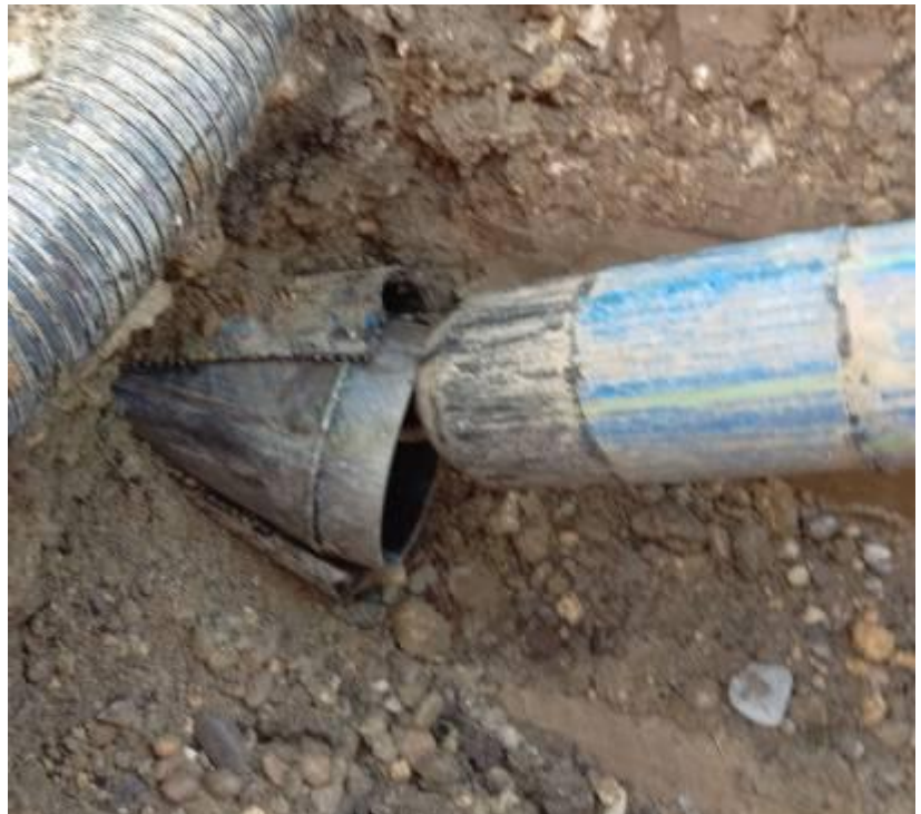
Bild 4: Das doppelte Zahnscheibenmesser ist bereits im Erdbreich verschwunden. Der Aufweitkonus drückt das geschnittene Altrohr sauber zur Seite.
