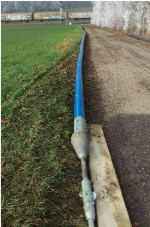
Bild 3: Das für den Einzug vorbereitete Neurohr.
