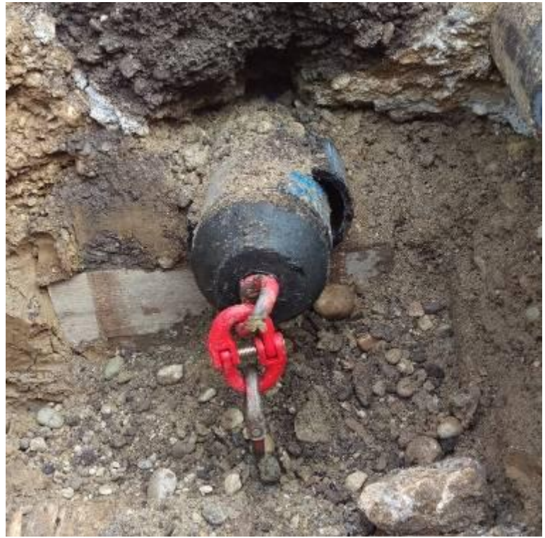
Bild 7: Das fertig eingezogene Schutzmantelrohr DA 160
