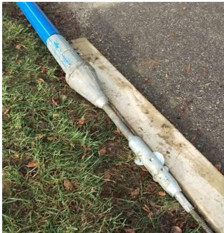
Bild 2: Am anderen Ende des Zugseils ist das doppelte Zahnscheibenmesser, der Aufweitkonus und das Neurohr montiert.
