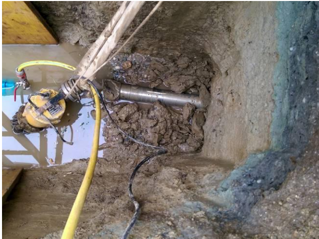
Bild 6: Zielgenaue Ankunft der Pilotbohrung in die schmale Zielgrube.
