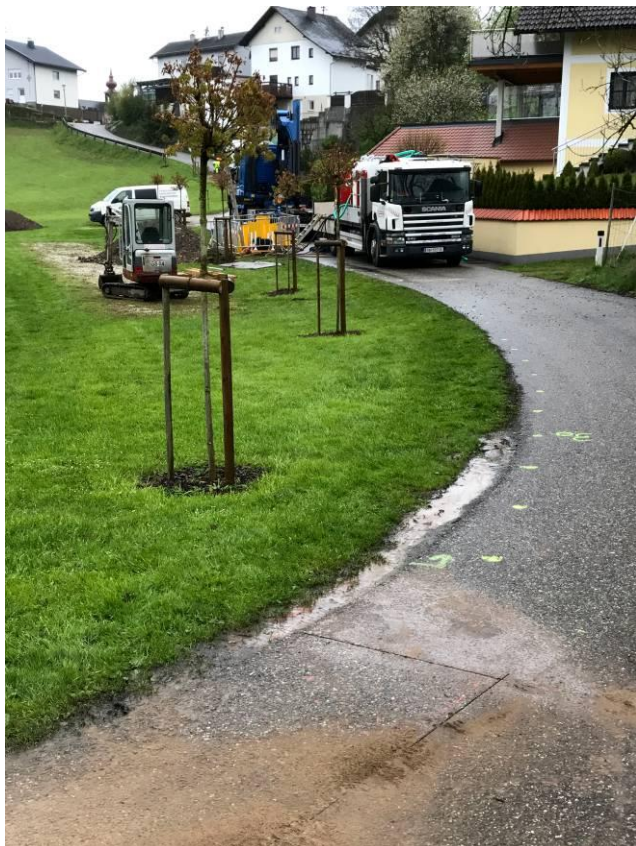
Bild 3: Die Gestänge erlauben einen Steuerradius von 24 m.
