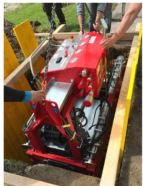
Bild 1 + 2: Der TJ 3008 ES kann in Gruben von einer minimalen Länge von 2.10 m installiert werden.
