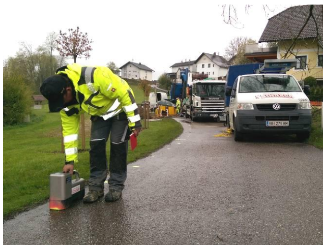
Bild 5: Polier Markus beim Orten mit dem DigiTrak F5.
