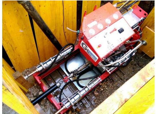
Bild 7: Das 90 mm Druckwasserrohr konnte mit dem TJ 3008 ES in kürzester Zeit eingezogen werden.
