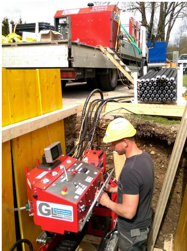
Bild 4: Bohrmeister Thomas beim Erstellen der ersten Pilotbohrung gesteuert über 42 m.
