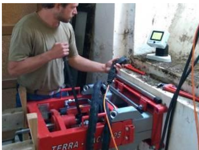
Bild 1: Bohrmeister Ivan Isch bei der gesteuerten Pilotbohrung aus dem Keller. Der TERRA-JACK ist dazu an die Kellerwand geflanscht.
