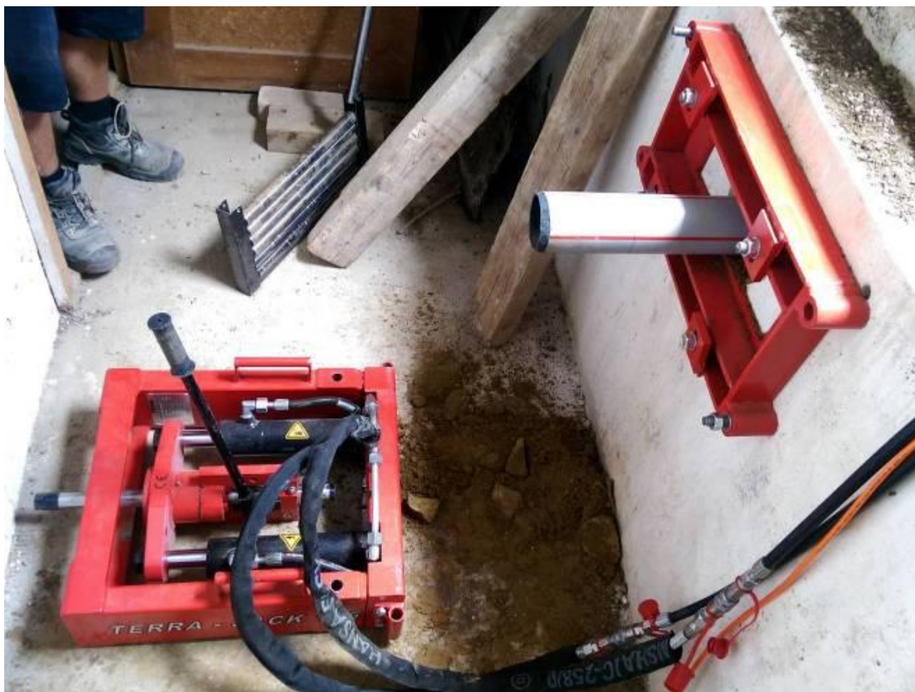
Bild 3: Die TERRA-JACK-Grundeinheit nach dem Rohreinzug und nach der Entnahme aus dem Wandflansch.
