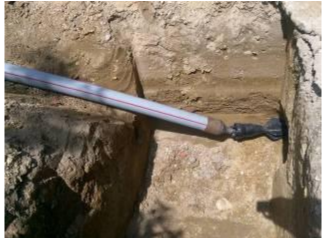
Bild 5: Einzug eines Kabelschutzrohres mit Aussendurchmesser 92 mm. Aufweitung und Rohreinzug erfolgen in einem Schritt.
