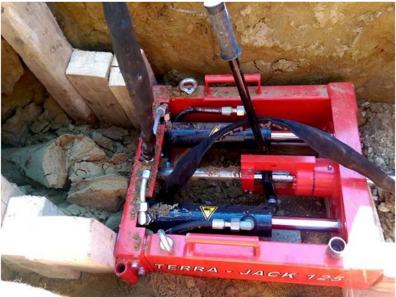
Bild 7: Der TERRA-JACK 125 zieht die Aufweitglocke mit bis zu 12.5 Tonnen durch den Boden. Hier kommt die Aufweitglocke zusammen mit dem Rohr am Ende des Einzuges in der Grube an.
