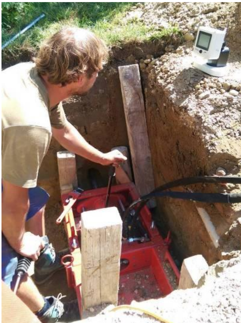
Bild 6: Der Bohrmeister überwacht das Signal – und damit die Position des Steuer-Presskopfes – auf dem Monitor.
