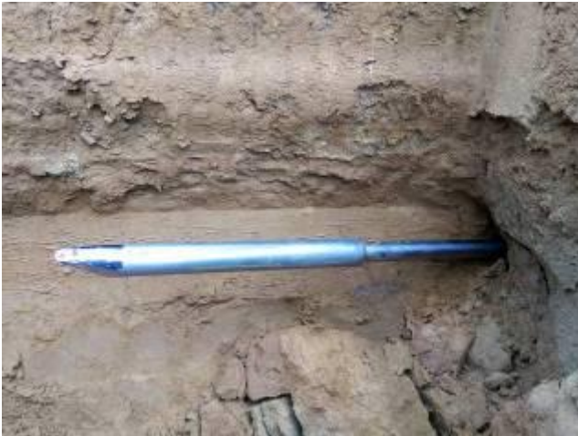
Bild 4: Die Pilotbohrung erreicht die Zwischengrube zielgenau in der Ecke, so dass daneben Platz bleibt für die anschließende Installation des TERRA-JACKs.
