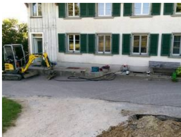
Bild 2: Der Antrieb erfolgte über den Kleinbagger. Die Hydraulikschläuche wurden durch den Lichtschacht am TERRA-JACK angeschlossen.
