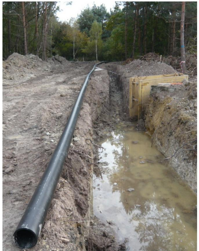
→ Das 60 m lange HDPE-Rohr DA 200 mm x 11.9 mm wird an der Zielgrube ausgelegt. Es ist bereit zum Rohreinzug.
