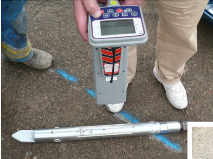
← Das Ortungsgerät wird vor der Pilotbohrung kalibriert.
