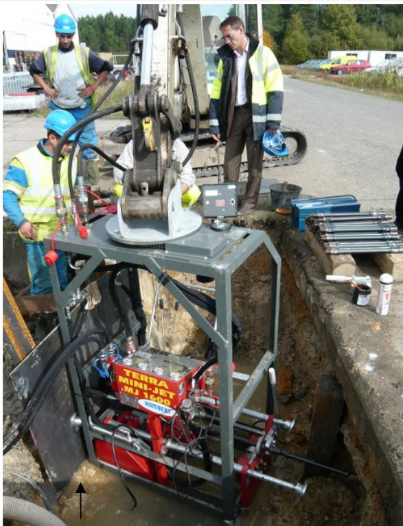
↑ Der TERRA MINI-JET MJ 1600 mit Baggerahmen während des Rohreinzugs. Das HDPE Rohr DA 200 mm wird über eine Länge von 47 m eingezogen.
