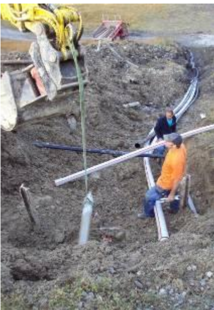
Der TERRA-HAMMER mit Aufweithülse und angehängtem Rohr erreicht den Zielgraben.
