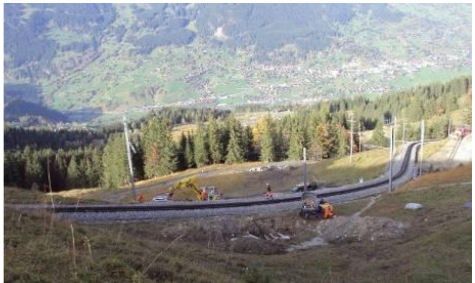
Übersicht auf die Baustelle. Die vier Rohre sind bereits verlegt. Im Hintergrund das Dorf Grindelwald.
