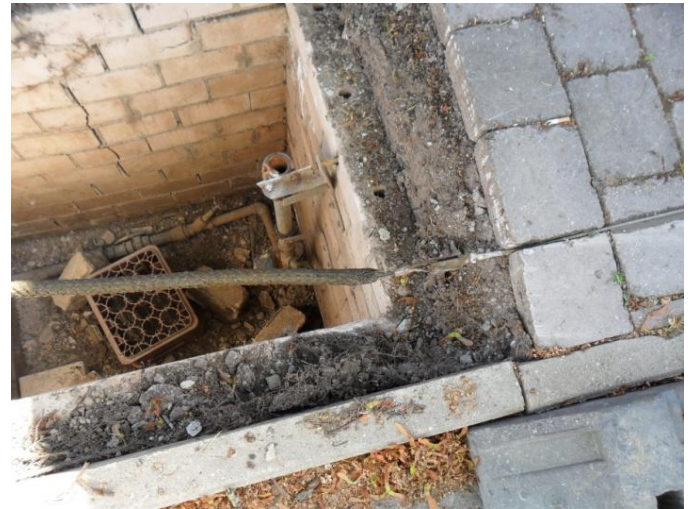
Das Zugseil wird mit einem Kabelziehstrumpf eingezogen.
