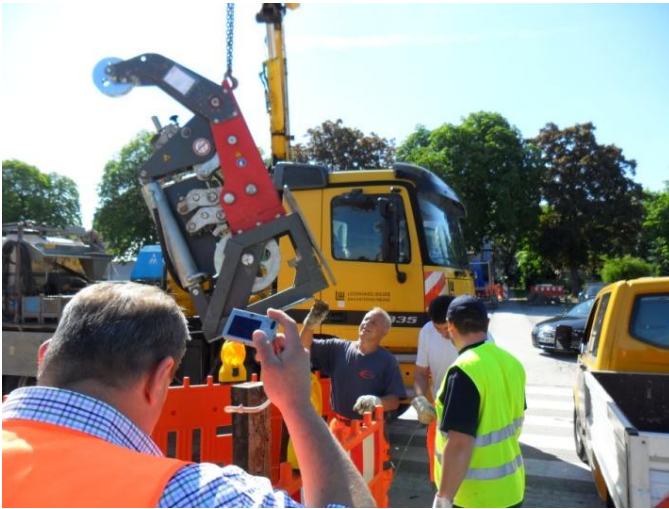
Der TERRA-EXTRACTOR X 400 wird entladen und in die Maschinengrube abgelassen.
