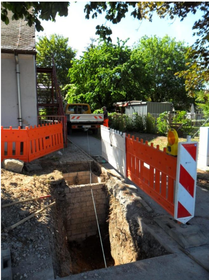
Das Zugseil wird mit einem Transporter in das Altrohr eingezogen
