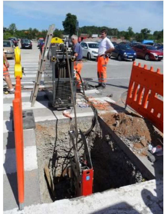
Die automatische Seiltrommel X 400 rollt das Zugseil synchron zum Rohreinzug auf.
