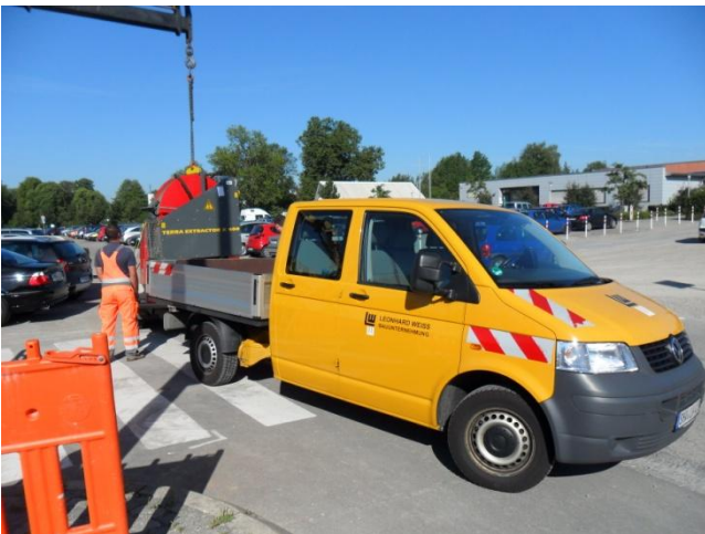
Die Seiltrommel wird entladen und positioniert.
