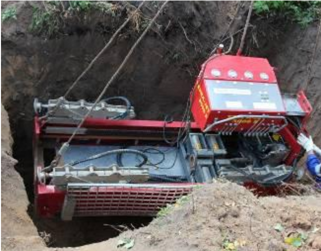
Der TERRA-JET 3008 E ist in der Startgrube installiert.
