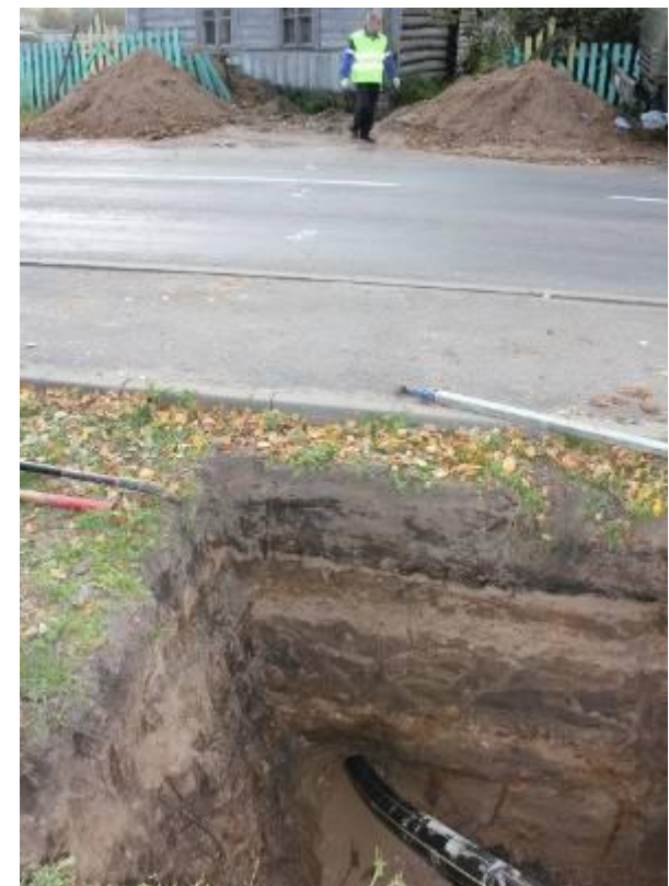
Das (erste) Rohr wird eingezogen.
