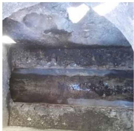
Blick in den Schacht auf das Altröhr.
