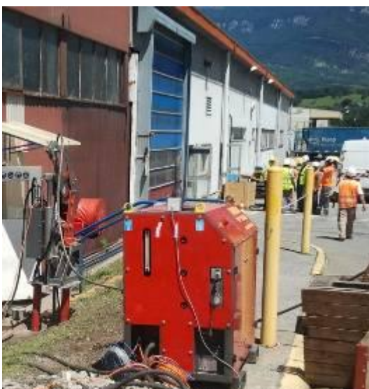
Blick auf eines der zu erneuernden Teilstücke.
