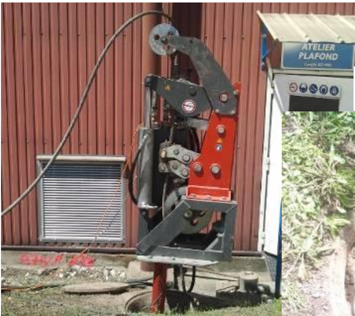
↑ Der Seilberster TERRA-EXTRACTOR X 400 wird über zwei Stützstreben auf den Schachtrahmen montiert.
