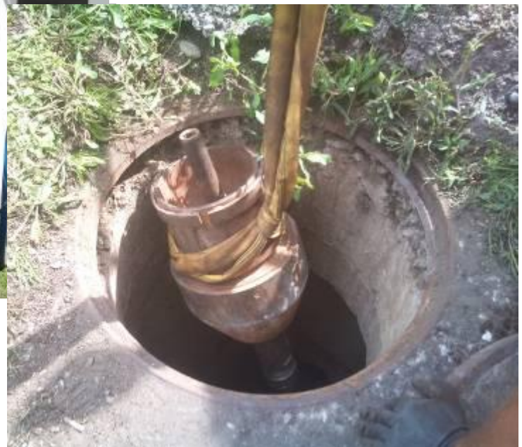
↓ Der Kaliberkopf Ø 295 mm wird in den zweiten Schacht abgelassen.
