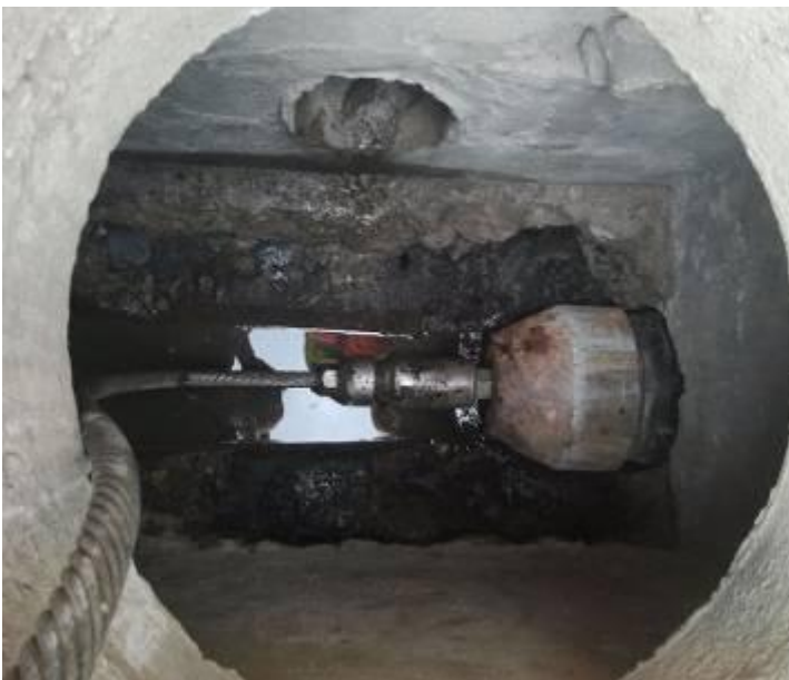
Der Kaliberkopf kommt im Zielschacht an.
