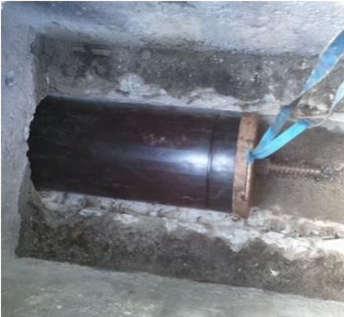
Ein Kurzrohr wird eingezogen. Dies dauert etwa 20 Sekunden.
