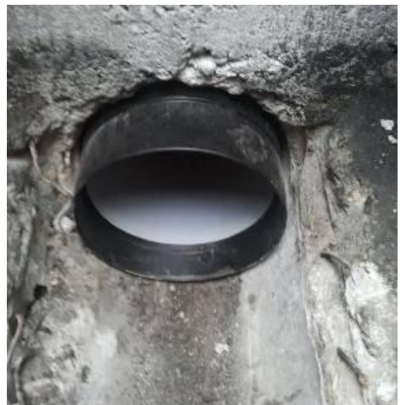
Der neue Rohrstrang ist verlegt.
