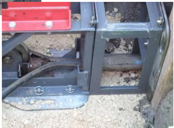
→ Das Neurohr erreicht den Seilberster X 100.
