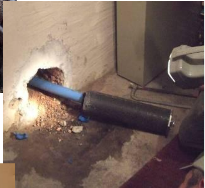
→ Die Abdichtung des Wanddurchbruchs.
