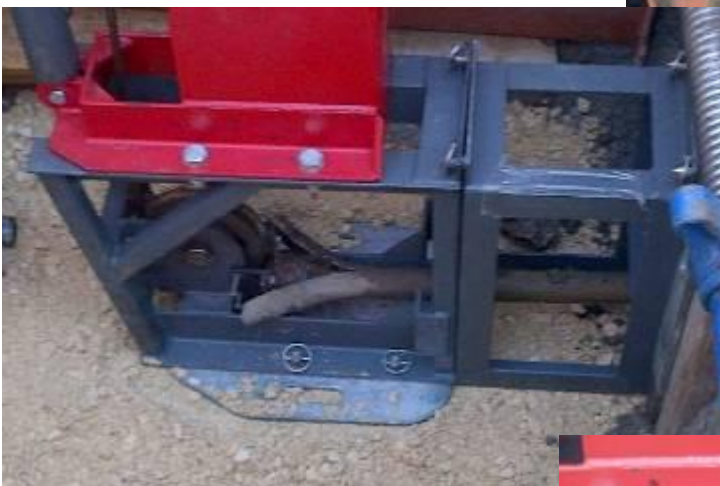
← Das Altrohr wird herausgedrückt und vom Auflaufkonus aufgeschnitten.
