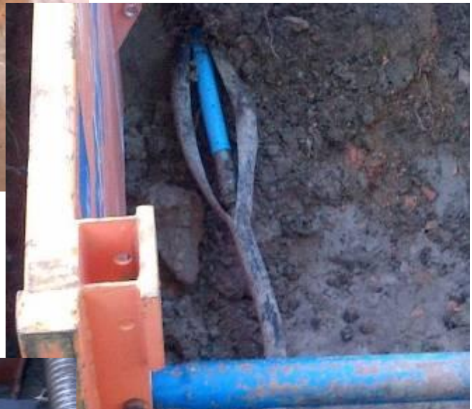
→ Das Altrohr wird in zwei Hälften aufgeschnitten und das (blaue) Neurohr eingezogen.
