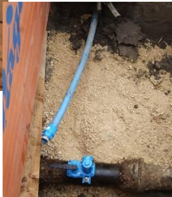
→ Die neue Leitung wird an die Hauptleitung angeschlossen.
