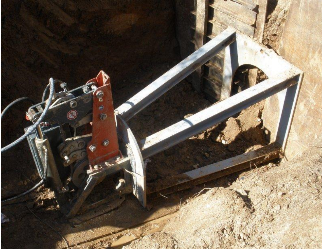
Der Seilberster X 400 mit Spezialvorbau für 500 mm Rohre
