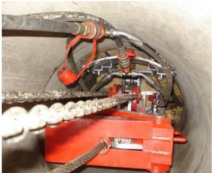
Der Seilberster X 300 C im Ø 800 mm Schacht
