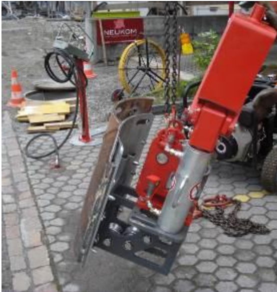
Der Seilberster X 300 C mit gebogener Frontplatte wird im Ø 800 mm Schacht installiert.
