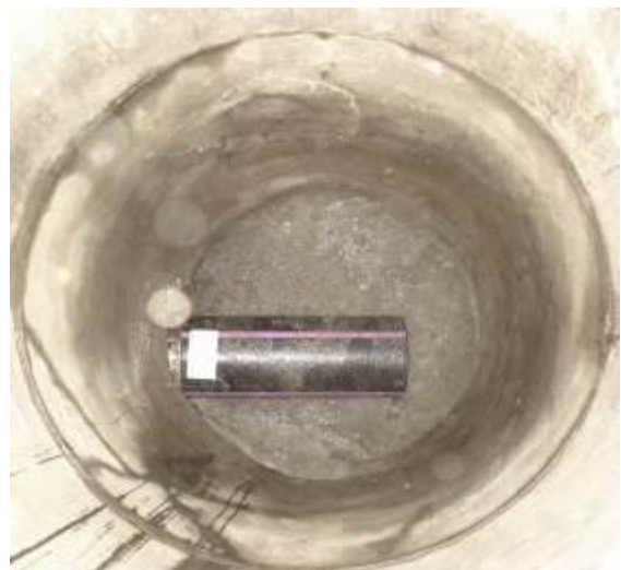
Eingeschraubtes Kurzrohrmodul
