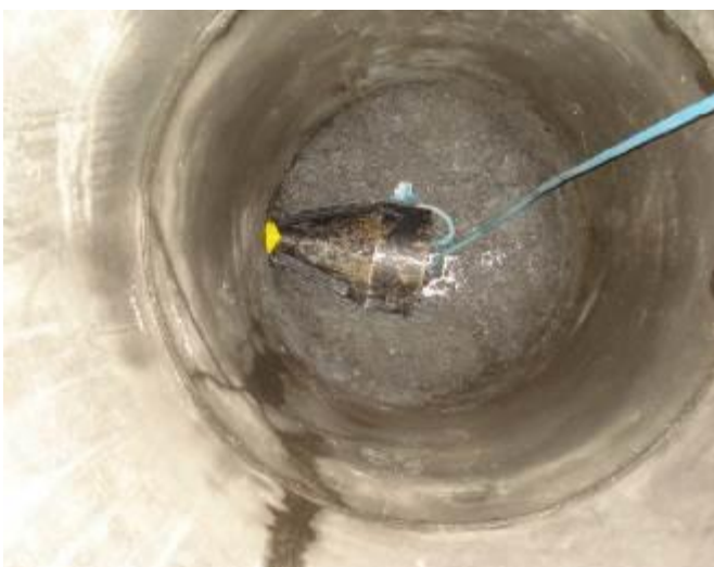
Der Berstkopf im 600 mm Schacht
