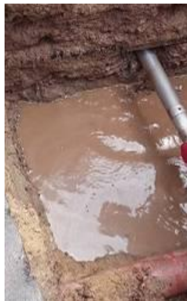
Trotz der schwierigen Bodenverhältnisse arbeitet sich der TERRA-HAMMER T 080mini SK mit dem Kombikopf zu seinem Ziel durch.
