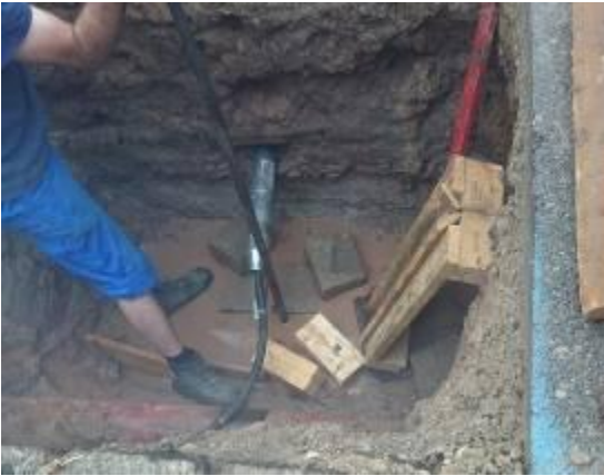
Nach leichter Korrektur bahnt sich der TERRA-HAMMER seinen Weg.
