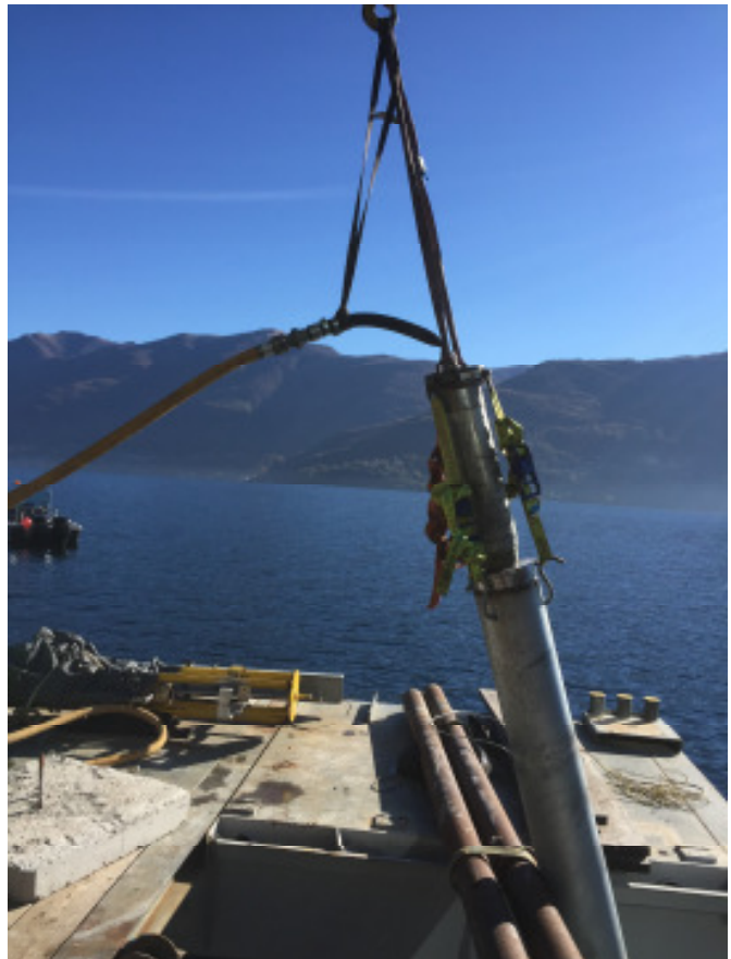
Bild 3: Die ganze Einheit wird mit dem Hebekran senkrecht angehoben.
