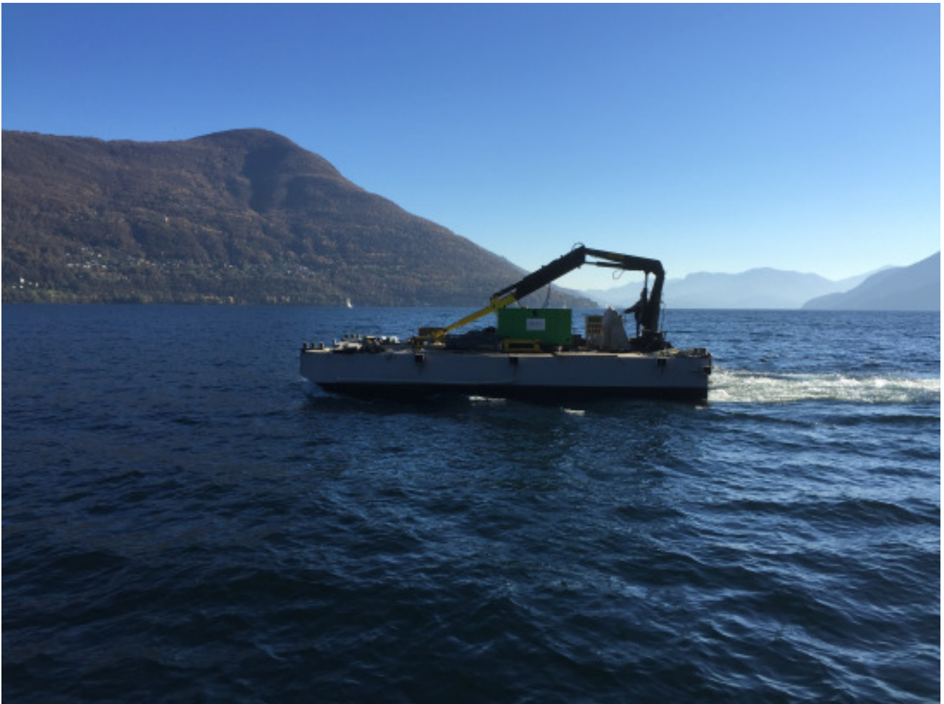
Bild 1: Die Arbeitsplattform bei der Überfahrt auf dem Lago Maggiore. Diese ist mit einem Hebekran, Druckluftkompressor sowie Notstromaggregat ausgerüstet. Die einzurammenden Stahlrohre und die Ramme wurden mit einem Hafenkran auf das Ponton gehoben.
