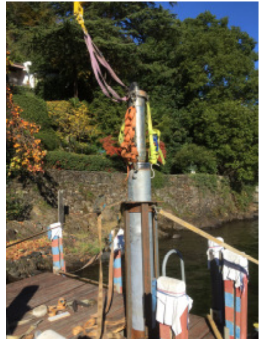
Bild 5: Die TR 200mini beim Einrammen des Stahlrohrs.
