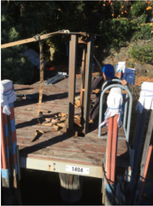
Bild 4: Zur senkrechten Stabilisierung des Stahlrohrs wird eine Führung auf den alten Steg aufgeschraubt und ausgerichtet.
