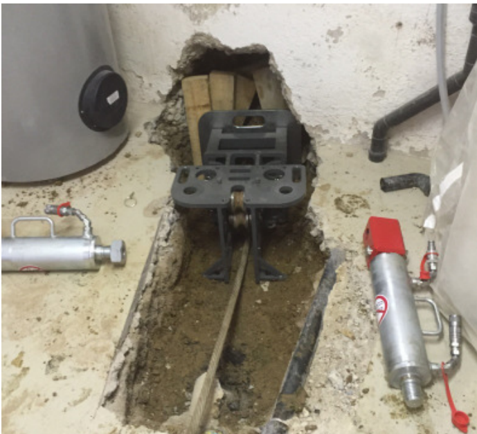
Bild 1: Der in Einzelteile zerlegte Seilberster wird im Keller zusammenmontiert.
