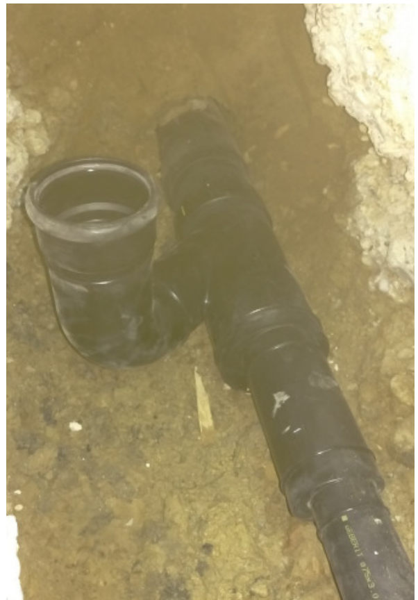
Bild 7: Mittels einer Reduktion vom Schraubrohrdurchmesser auf DA 160 mm wird das bestehende hausinterne Abwassersystem an die Neuleitung angehängt. Vor Inbetriebnahme wurde die neue Leitung mittels Druckprobe geprüft.
