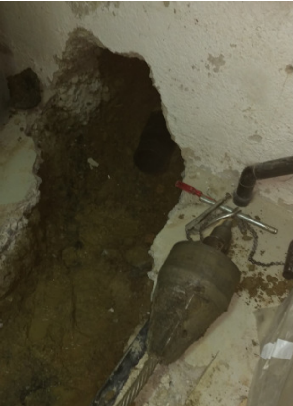
Bild 6: Nach der Ankunft des Berstwerkzeugs im Keller werden dieses und der Seilberster demontiert.
