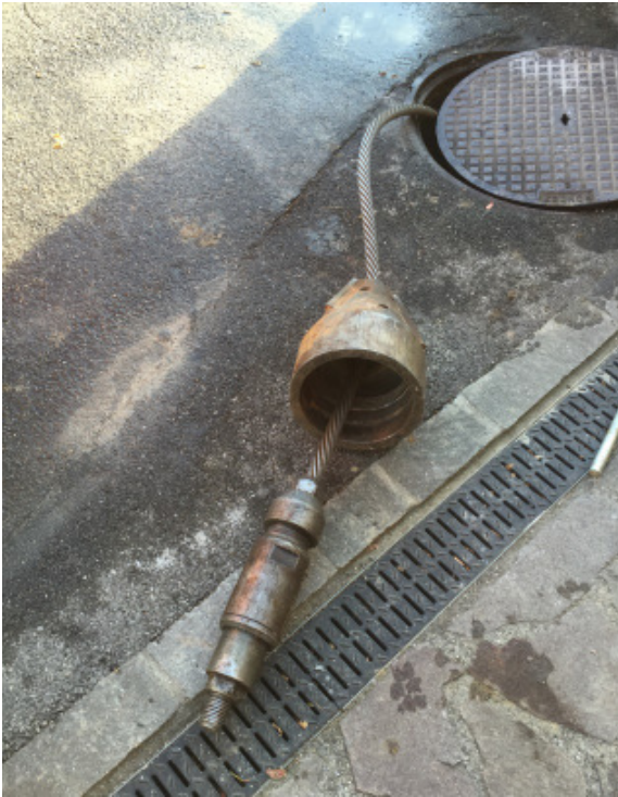
Bild 3: Auf das Zugseil wird der Kurzrohrberstkopf aufgefädelt und am Ende die Seilkupplung montiert.
