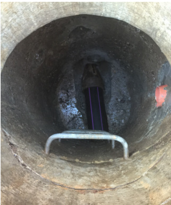
Bild 5: Der Berstkopf mit dem ersten Kurzrohr DA 180 mm liegt im Durchlaufschacht zum Einzug bereit. Nach dem Einzug des ersten Rohres werden kontinuierlich neue Schraubrohre angeschraubt.
