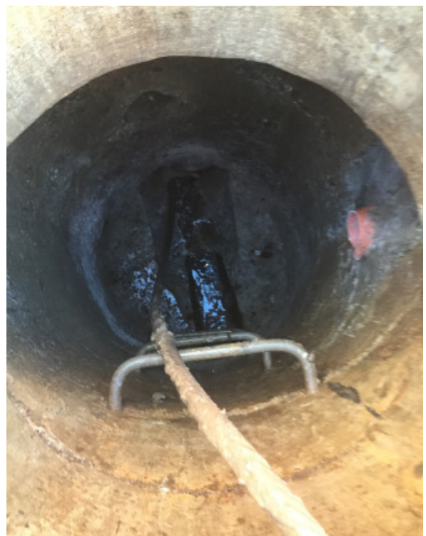
Bild 2: Das Zugseil wird durch die Altleitung durchgezogen.
