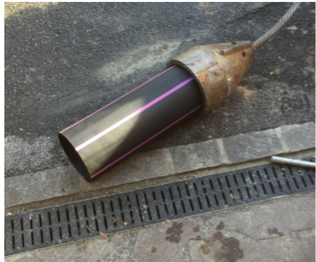
Bild 4: Anschliessend wird das erste Kurzrohr in den Berstkopf geschraubt.
