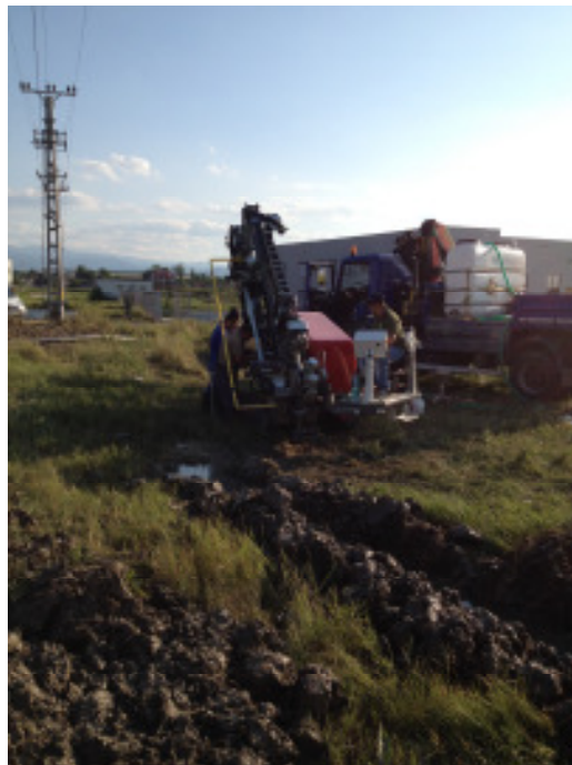
Bild 5: Anschliessend musste der TERRA-JET TJ 2808 S zum vertikalen Bohren umgebaut werden. Dieser Umbau kann in ca. 30 Minuten auf der Baustelle realisiert werden.
