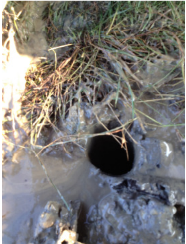
Bild 7: Nach 1 ½ Stunden waren 25 Meter vertikal gebohrt. Damit das Bohrloch \varnothing 100 mm sauber bleibt und nicht zusammenfällt, wurden 100 ltr/min Bentonit in das Bohrloch gepumpt.
