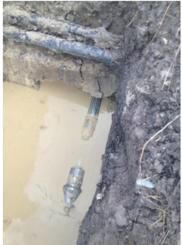
Bild 3+4: Nach erfolgreicher Pilotbohrung wurde ein Räumler DA 160 mm montiert, um ein HDPE Rohr DN 110 mm einzuziehen. Nach nur 30 Minuten war das Rohr über 35 Meter eingezogen.
