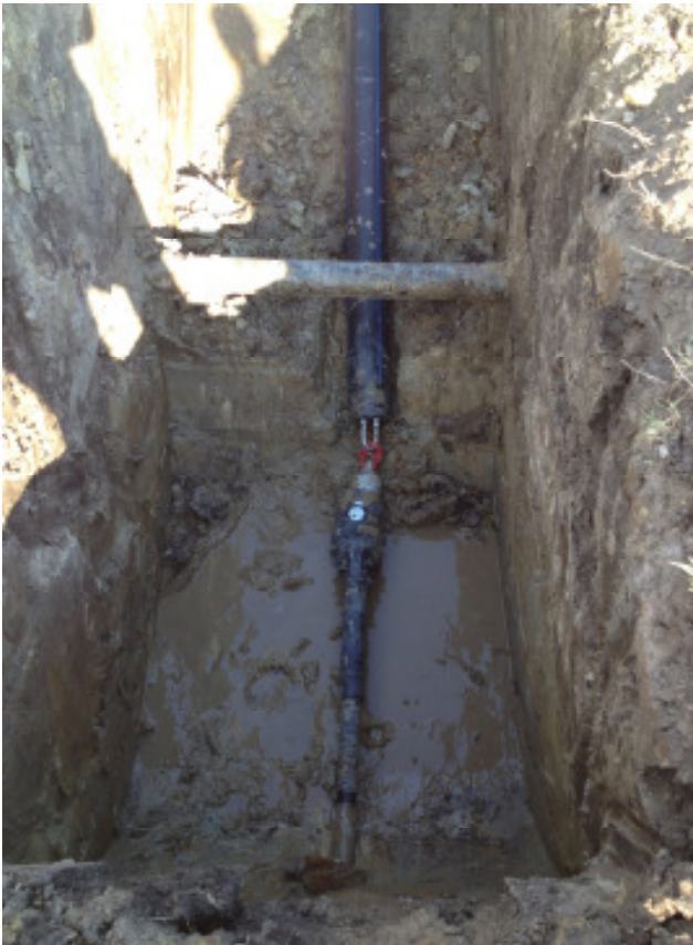
Bild 3+4: Nach erfolgreicher Pilotbohrung wurde ein Räumler DA 160 mm montiert, um ein HDPE Rohr DN 110 mm einzuziehen. Nach nur 30 Minuten war das Rohr über 35 Meter eingezogen.
