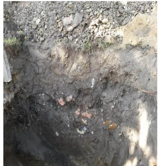
Bild 3+4+5: Zusätzliche Schwierigkeit, der Boden war aufgefüllt und verdichtet. Sehr viele Abbruchsteine, Betonbrocken, Tonscherben und Feldsteine bis in ca. 2m Tiefe erschwerten die Pilotbohrung. Erst darunter befand sich gewachsener Boden (Lehm Sandgemisch).
