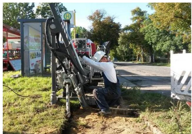
Bild 6+7: Der TERRA-JET in Bohrposition. Dank des verstellbaren Bohrwinkels von bis zu 67 % wird die gewünschte Bohrtiefe schnell erreicht. Die kompakten Bauweise macht auch das Verankern einfach.
