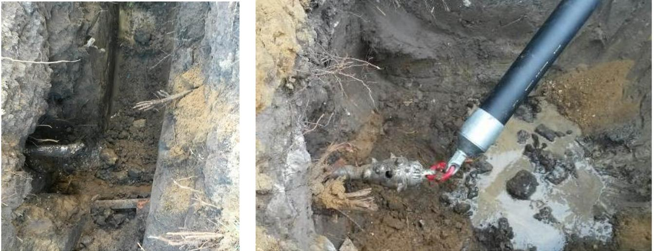
Bild 9: Der Rohreinzug verlief nachfolgend reibungslos und entsprechend schneller. Mit der Pilotbohrung existierte bereits ein 100 mm Bohrkanal und man benötigte für das Rohr DA110 lediglich einen Räumer mit 160 mm. So war das Rohr nach 45 Minuten am Ziel.
