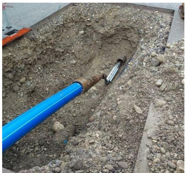
Bild 4 + 5: Das Altrohr wird mittels eines Rollenmessers unten aufgeschnitten. Hinter dem Rollenmesser werden der Aufweitkonus und das neue Schutzmantelrohr montiert.
