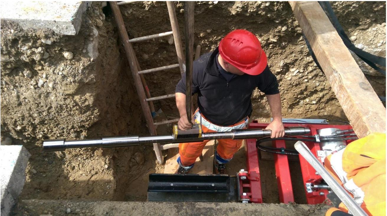
Bild 1: Die Montage der Zugstange erfolgt mit einem Kran. Das Gestänge wird dabei magnetisch gehalten.
