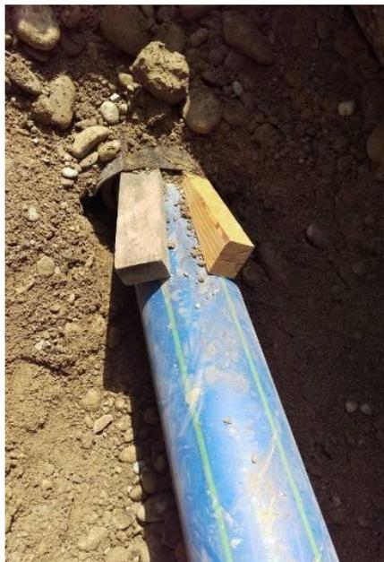
Bild 6: Einlauf des Neurohrs in das geschnittene Altrrohr.
