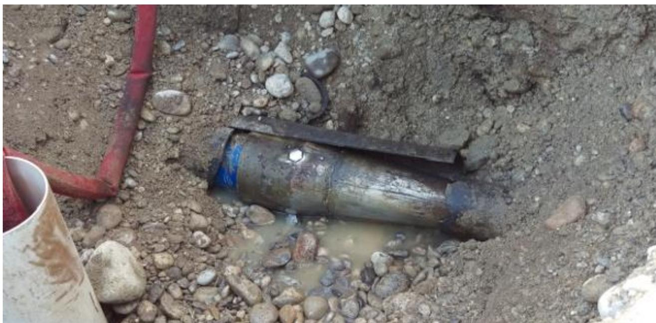
Bild 9: Der Aufweitkonus mit angehängtem Schutzmantelrohr durchfährt die Zwischengrube.
