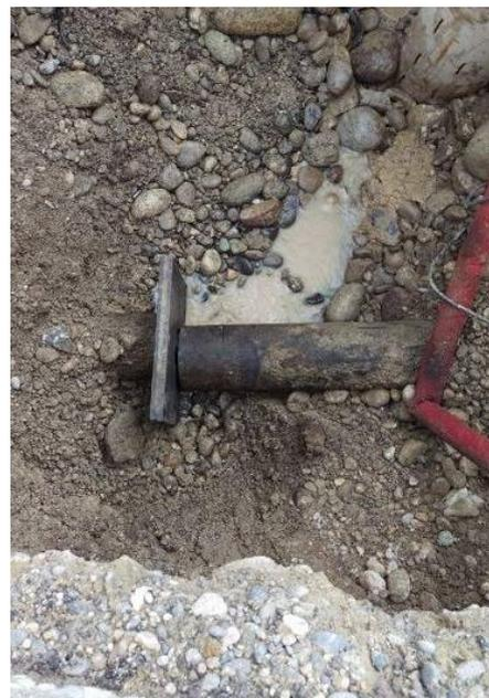
Bild 8: In dieser Grube wurde im Voraus ein Formstück entfernt. Um zu vermeiden, dass sich die Altröhre ineinander schieben, wurde eine Zwischenplatte montiert.
