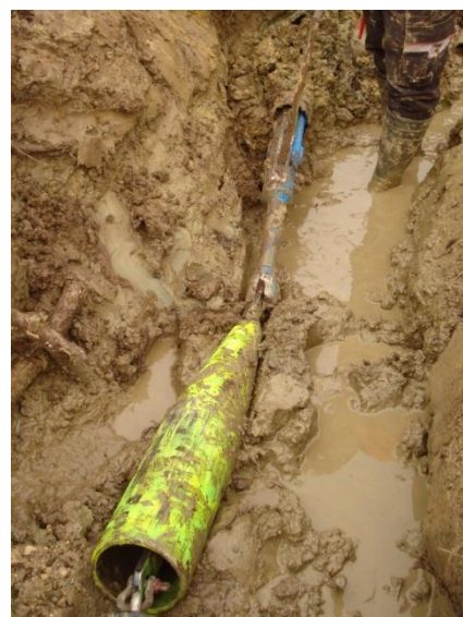
Bild 2: Aufweitkonus, um das geschnittene Altrohr zu verdrängen.
