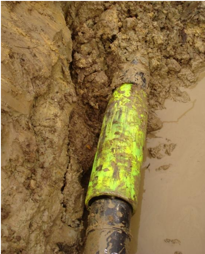
Bild 3 + 4: Als Neurohr wurde ein spiegelgeschweißtes HD-PE Rohr mit Aussendurchmesser 110 mm eingezogen. Die Rohrsanierung erfolgte in zwei Teilstücken mit 1x 95 m und 1x 70 m Länge.
