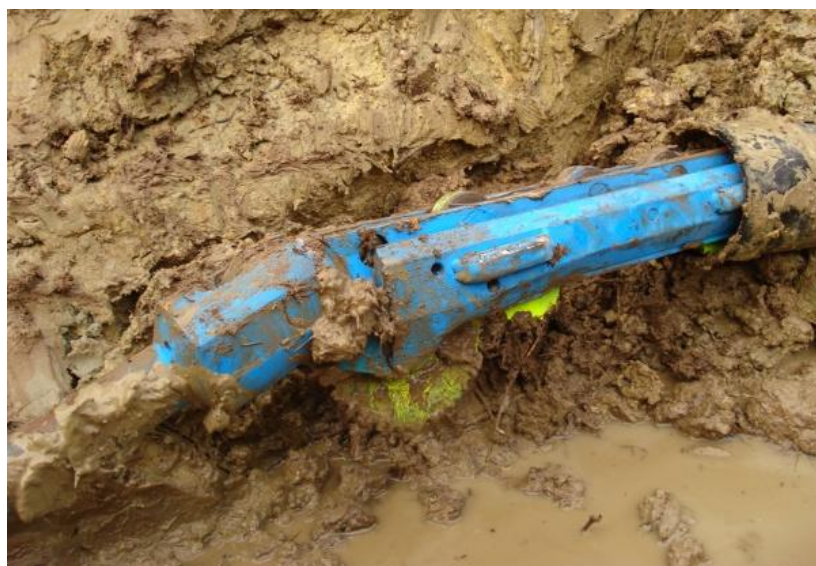
Bild 1: Das Zahnscheibenmesser beim Einlauf in das Altrohr.
