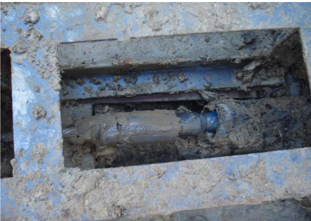
Bild 5: Die Seilkupplung mit dem dahinter angehängtem Berstwerkzeug erreicht die Zugrube.
