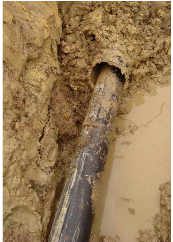
Bild 3 + 4: Als Neurohr wurde ein spiegelgeschweißtes HD-PE Rohr mit Aussendurchmesser 110 mm eingezogen. Die Rohrsanierung erfolgte in zwei Teilstücken mit 1x 95 m und 1x 70 m Länge.
